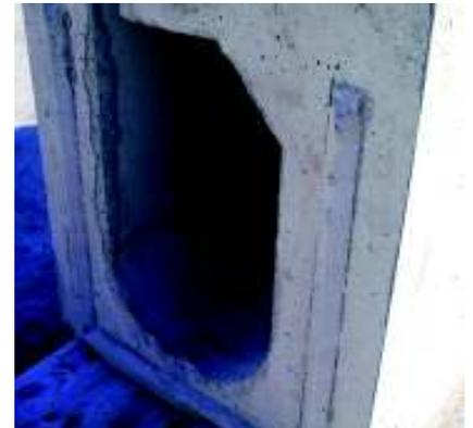
giunto a tenuta idraulica (maschio)
